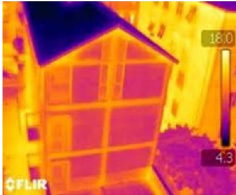
Termografia Copertura Isolata
