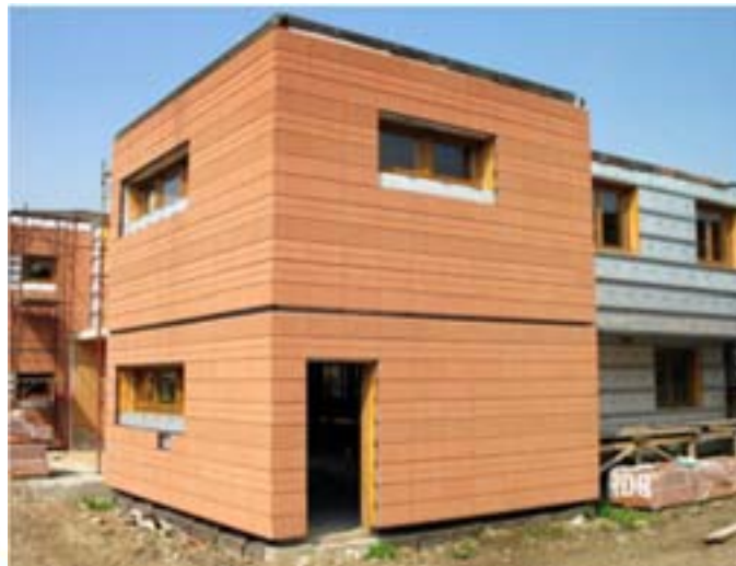
Fasi di cantiere
